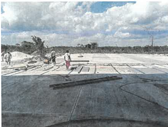
Forjado de andador de comunicación entre canchas
