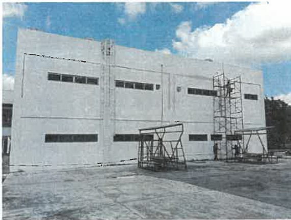
Tratamiento a juntas frías en fachada lateral
