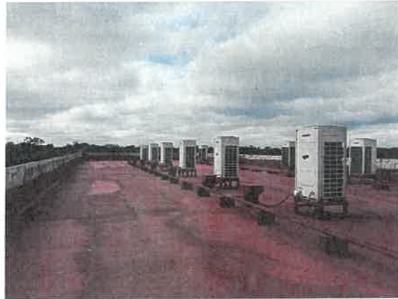
Impermeabilizante nuevo aplicado
