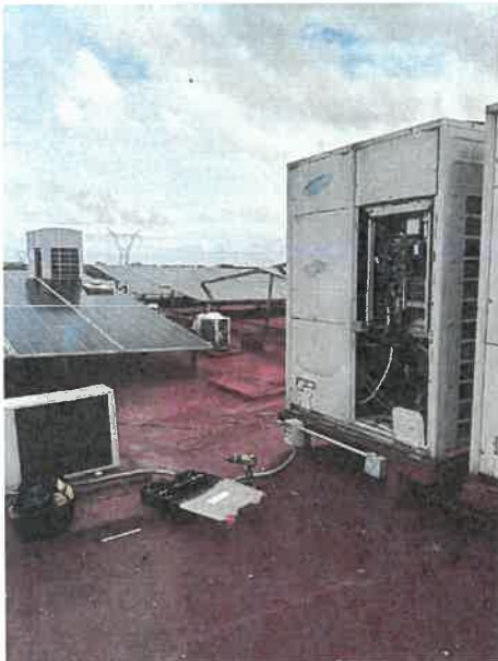
Instalación de compresores
