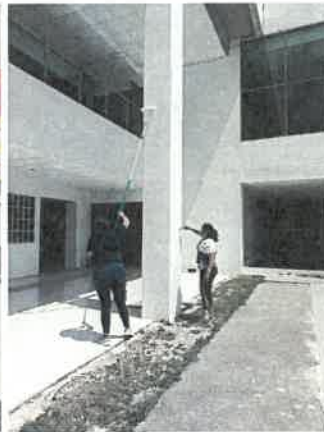
Aplicación de pintura
