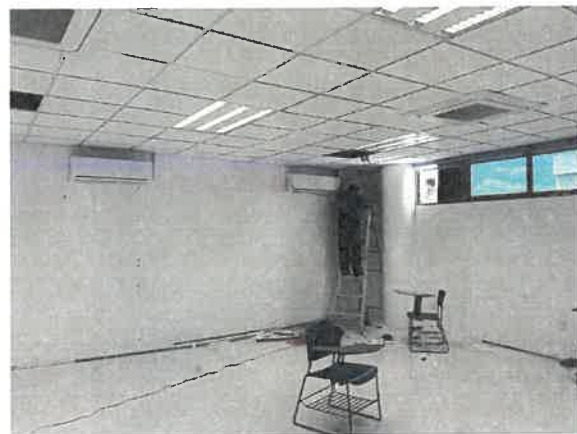
Instalación de equipos de aire acondicionado
