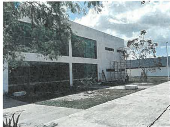
Tratamiento a juntas frías en fachada posterior
