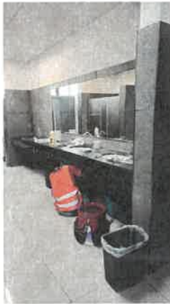
Revisión de tuberías
