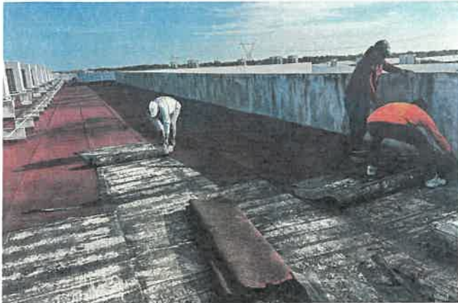
Retiro de impermeabilizante anterior
