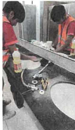
Sustitución de llaves
